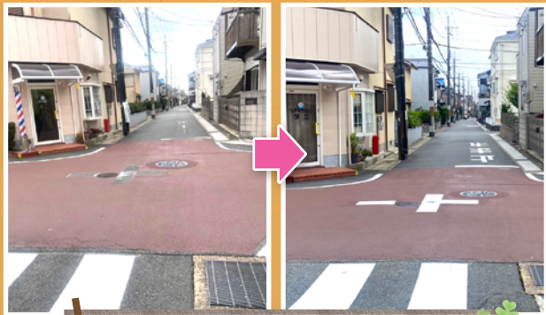
交差点修繕完了(西大久保小学校区)
